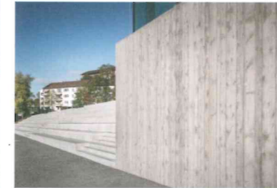
Pilatus Akademie, Luzern Ausbildungsstätte . 2014 Die vertikalen Strukturen wurden mit gehobelten Brettern für den Sichtbetontyp 3 geschaffen.
