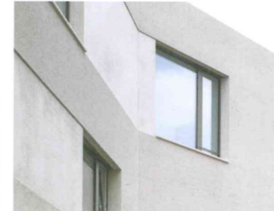
Bankstrasse, Hochdorf Wohn- und Geschäftshaus . 2013 Der Kalksteinbeton eignet sich für farbliche Akzente an Sichtbetonteilen. Oft wird die Oberfläche der Sichtbetonfläche mechanisch bearbeitet, um so die Farbe des Kalksteins zur Geltung zu bringen.
