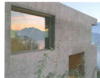
Huse, Vitznau Ferienhaus . 2011 Die gejettete Betonfassade, durch Bestrahlung aufgeraut, nimmt dank der Beimischung von Weserkies die rötliche Farbe und Körnung der markanten rückseitigen Nagelfuh auf. (Architekturbüro: alp architektur lischer partner ag)
