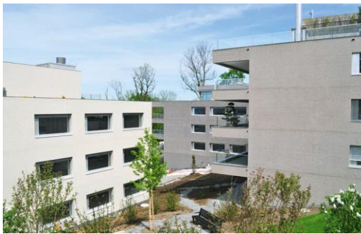
Kalksteinbeton Hänibüel, Zug, Landis Bau AG, Zug
