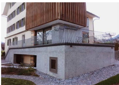
Umbau Wohnhaus Schwyz, Reichlin Bau AG, Ibach
