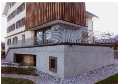
Umbau Wohnhaus Schwyz, Reichlin Bau AG, Ibach
