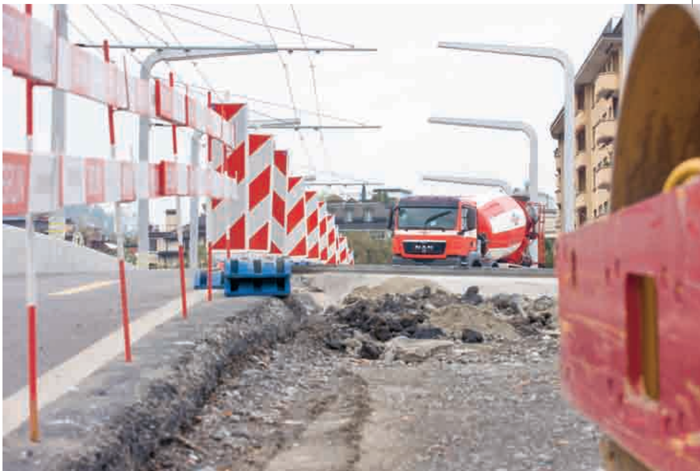
Langensandbrücke Luzern: SEEKAG ist als Betonlieferant ein grosser Gewinn für die Stadt Luzern.
