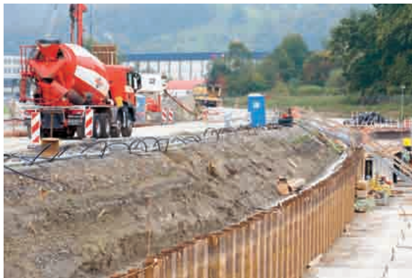
Tieflegung Zentralbahn: SEEKAG liefert auch an die Grossbaustelle auf der Allmend, am Fusse des Pilatus.
